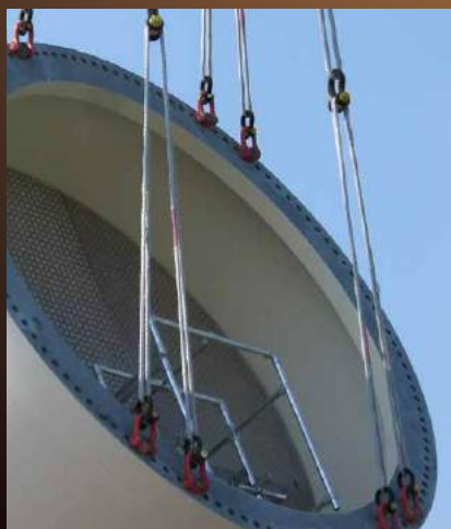
コンクリート構造物吊上移動 (フランス)
