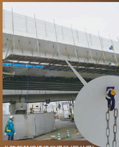
北陸新幹線橋梁足場吊 (福井県)
