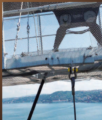
イスタンブールボスポラス海峡大橋 補修工事 (トルコ)
